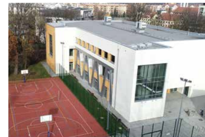
Figura 11: Ejemplo de instalación escolar ©FLOWAIR
