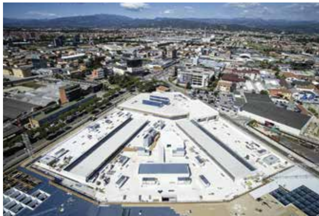
Figura 13: Ejemplo de instalación en un local de ocio ©MEHITS
