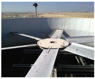
Figure 30: Aluminium fan inside fan stack
